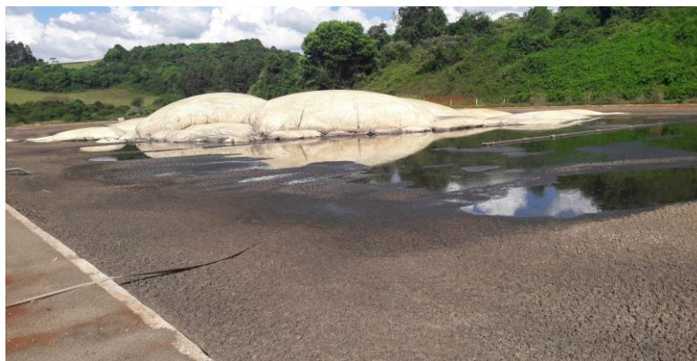
Figura 3 - Biodigestor da São Roque II desativação/fatores climáticos e Sedimentação de lodo Fonte: autores em 10 mar. 2017.
