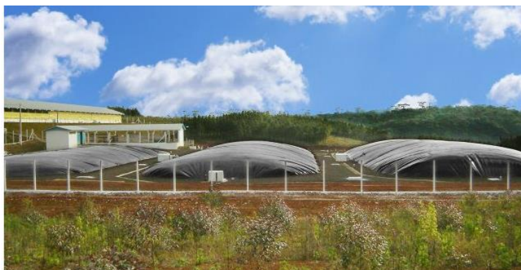
Figura 2: Biodigestores: grandes lonas infladas com o biogás (Aurora) foto: Gter Energias Renováveis.
